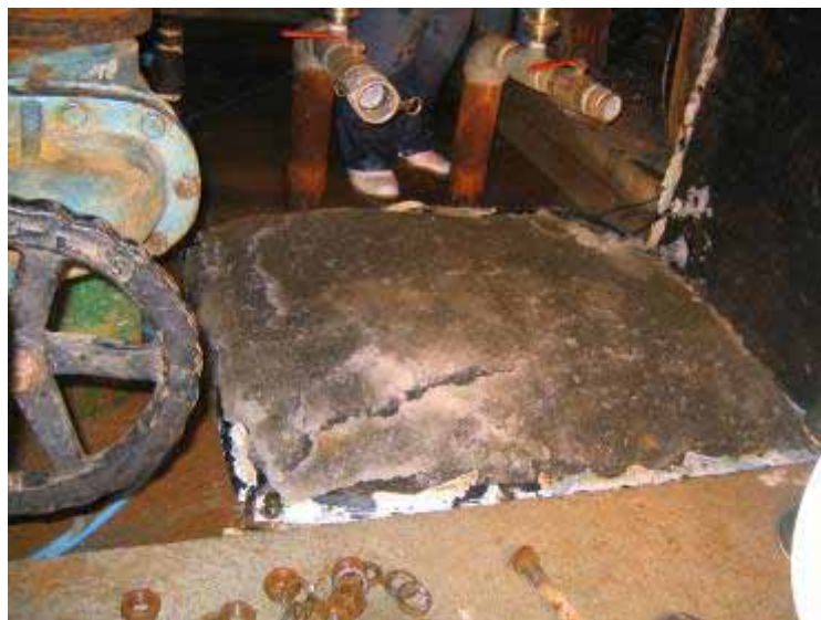
坑口開放直後
