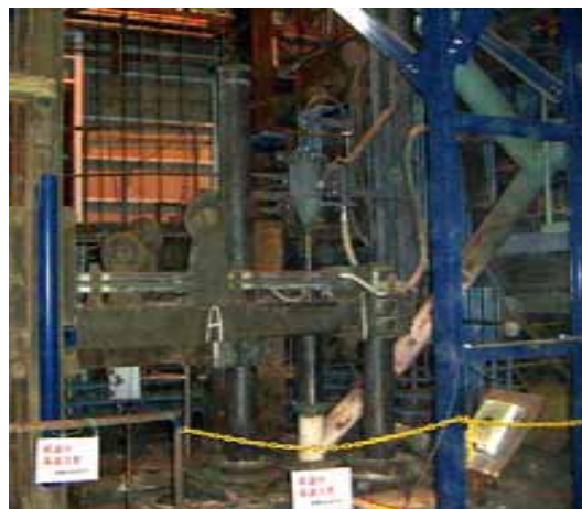
天盤上部設備
