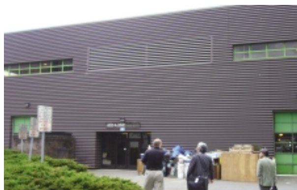
写真 14 : 資源工学科実験棟
