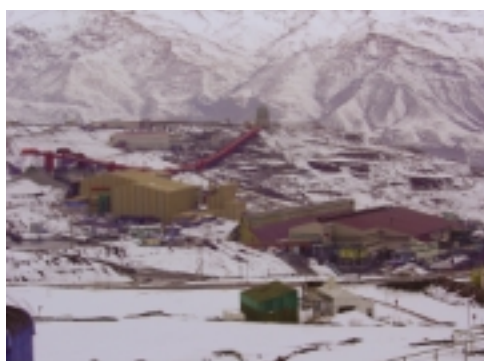
写真1：El Teniente銅山Colon（コロン）選鉱場（2000～2003年間に拡張され、年間鉱石処理能力4,700万tとなった。）
