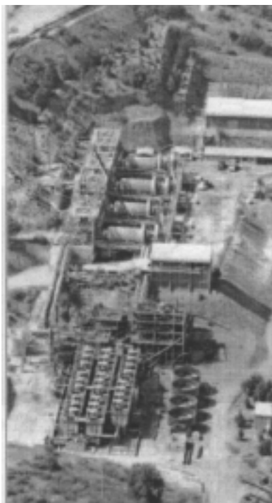
写真4：MVC選鉱設備 （尾鉱処理量4,400万t/y）
