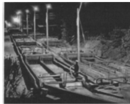
写真7：MVCのCascade（カスケード）浮選設備 （段差を付けた水路を自然流下する過程で空気を水中に取り込み水泡を生じさせる、言わば省エネ型浮遊選鉱設備で1914年にBroken Hill鉱山で初めて適用された。）
