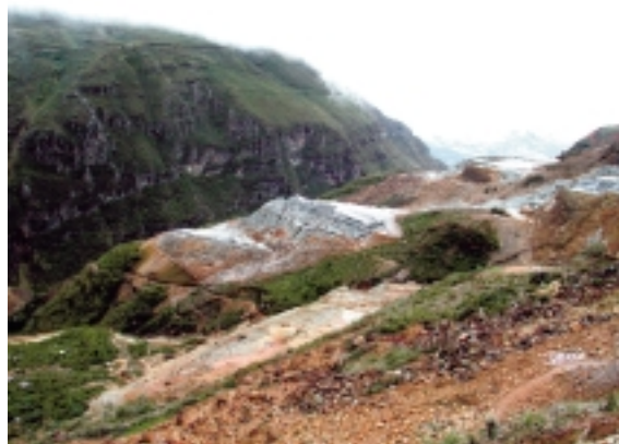
エル・ドラド尾鉱堆積場
