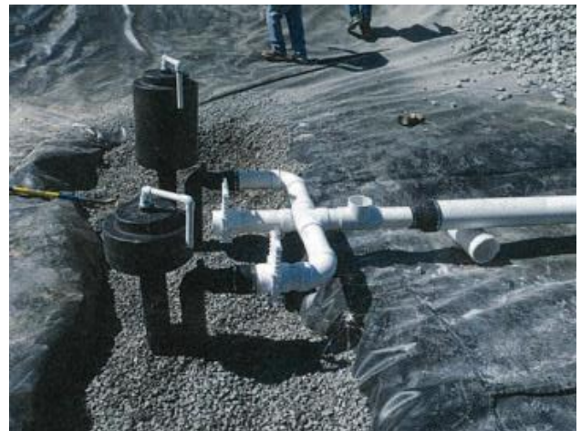
建設途中の AFVFP におけるサイフォンの様子
