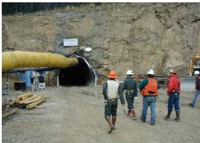
写真 2. Pogo 鉱床探鉱坑道の坑口
